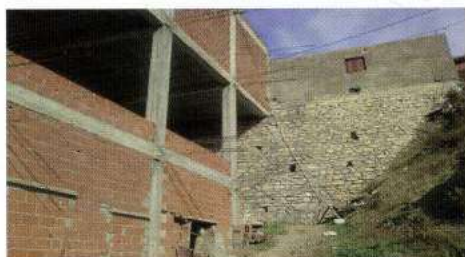
Figure 9 : Image de l'immeuble Taleb Ahcène.
