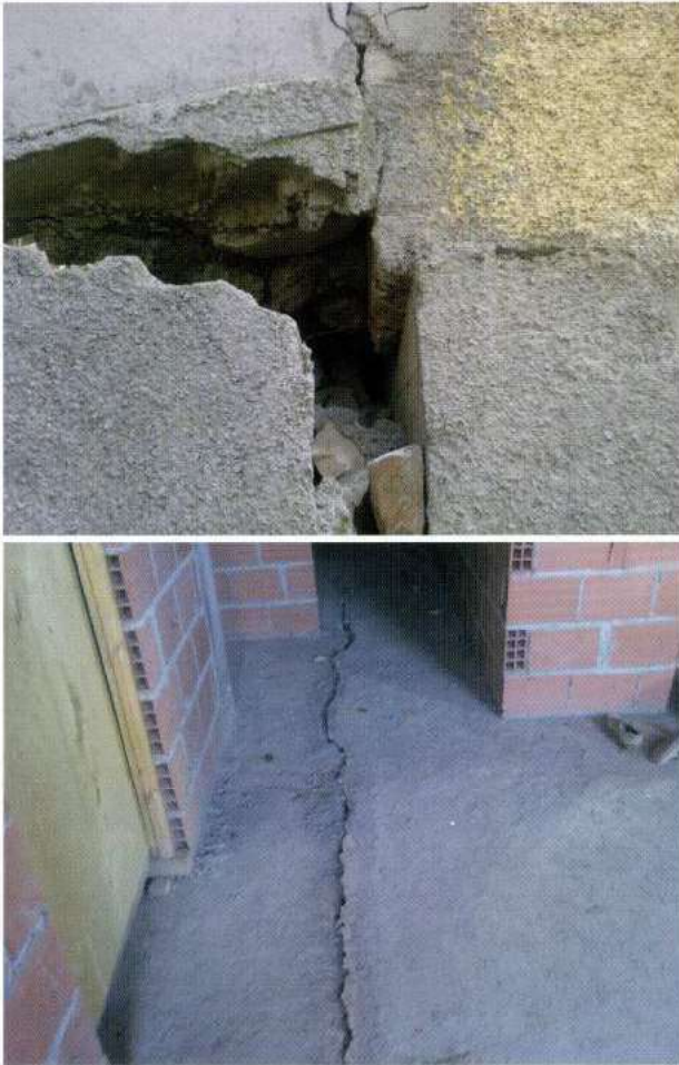
Figure 14: Conséquence de l'effet de la pente sur deux structures à Ain El Hammam.
